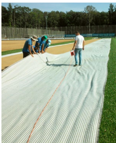
Inštalácia resp. polozenie hybridného koberca
