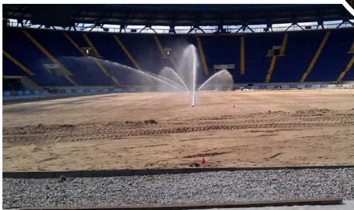
Inštalácia hornej koreňovej zóny - kremičitý piesok praný, príp. zmes piesku a rašeliny
