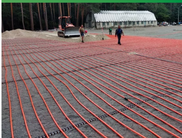
Inštalácia vykurovacieho potrubia
