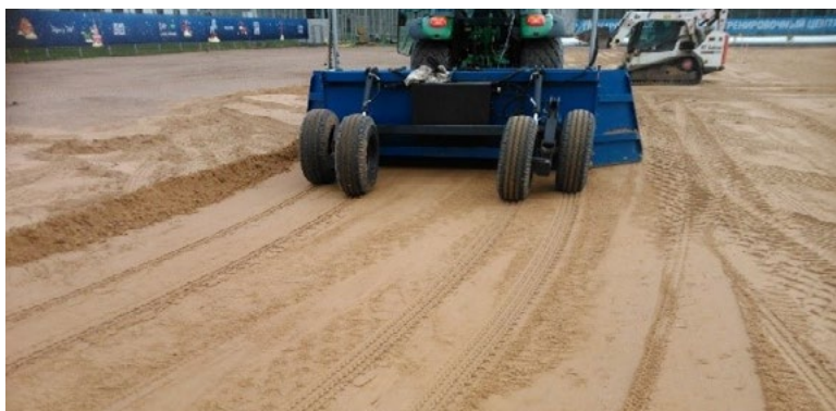
Inštalácia hornej koreňovej zóny - navrstvenie rašeliny a premiešanie rašeliny s pieskom.
