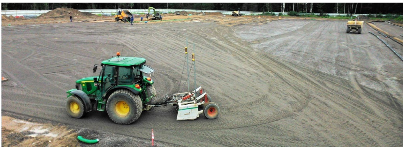
Navezenie drenážneho koberca 10 cm s následným vypádovaním laserovým grédrom
