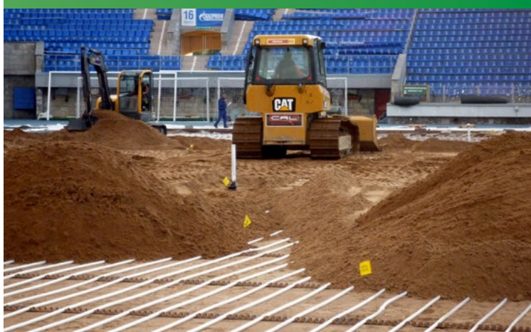
Inštalácia spodnej koreňovej zóny 20 cm – kremičitý piesok praný
