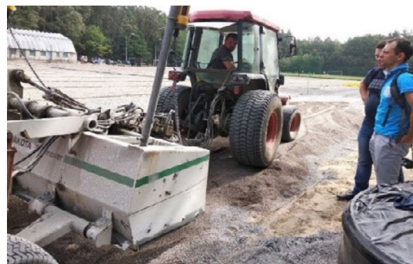
Vyrovnanie resp. vyspádovanie laserovým grédrom.
