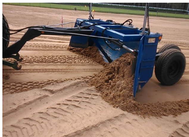
Vyrovnanie resp. vypsádovanie laserovým grédrom
