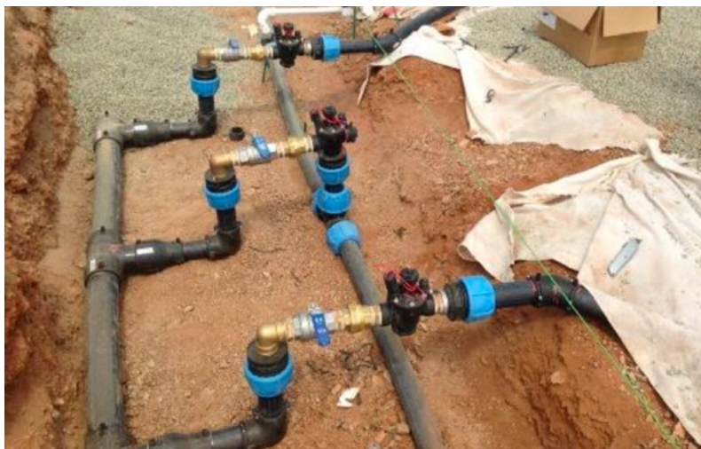
Inštalácia závlahového systému
