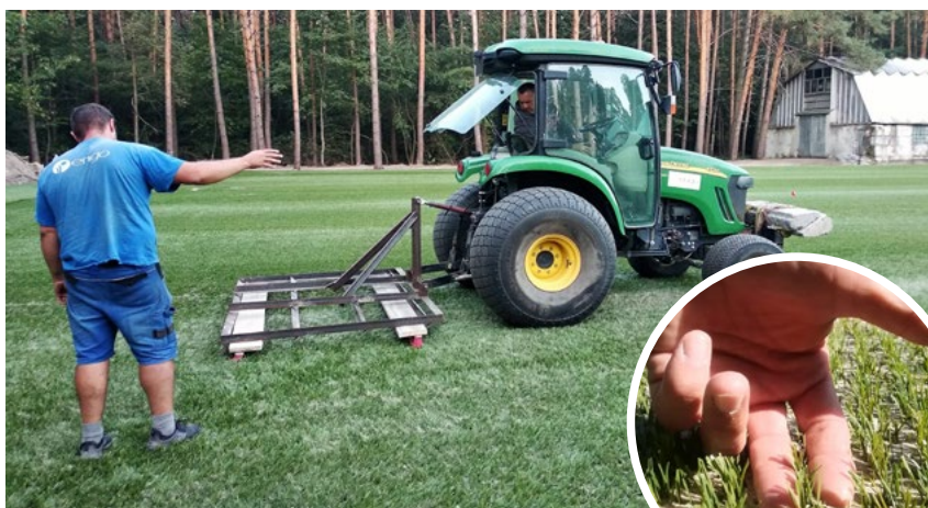
Zasypanie hybridného koberca kremičitým pieskom - do výšky 4 cm
