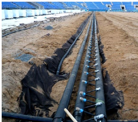
Inštalácia kolektora výhrevu
