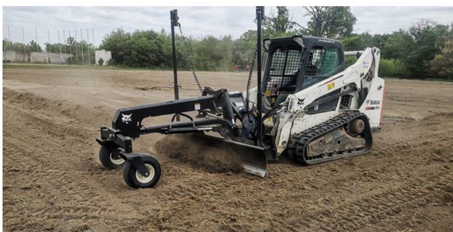
Nakyprenie povrchu do hĺbky 8-10 cm
