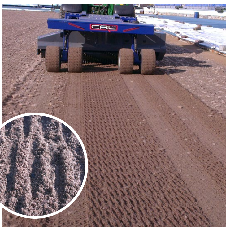
Vyrovnanie vrchnej koreňovej zóny.
