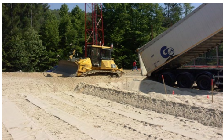
Inštalácia hornej koreňovej zóny - kremičitý piesok praný
